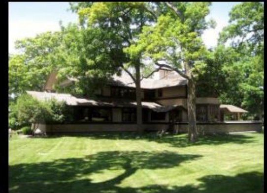
B. Harley Bradley House Kankakee, IL
